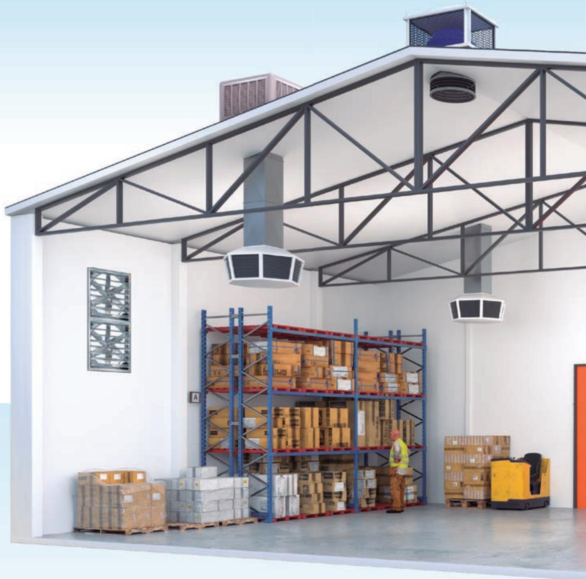
La climatización evaporativa es una tecnología que consiste en enfriar el aire caliente exterior obligándolo a pasar a través de un panel empapado en agua. De esta forma el aire exterior que esté a una temperatura de 35°C podemos introducirlo a una temperatura de 24°C, consiguiendo un ambiente confortable en el interior de la estancia.
