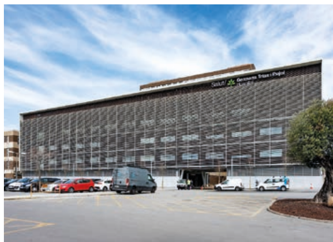
Instalación de más 260 unidades CLAGE mod. CEX para el Hospital Hermanos Trias i Pujol (Barcelona)
