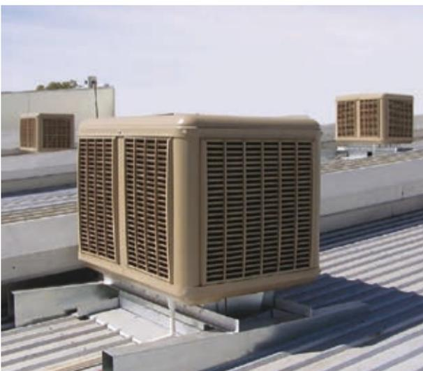
*Debido a su poco peso, no es necesaria una grúa para su montaje, ni soporte para su instalación, bastando con su propio conducto*
