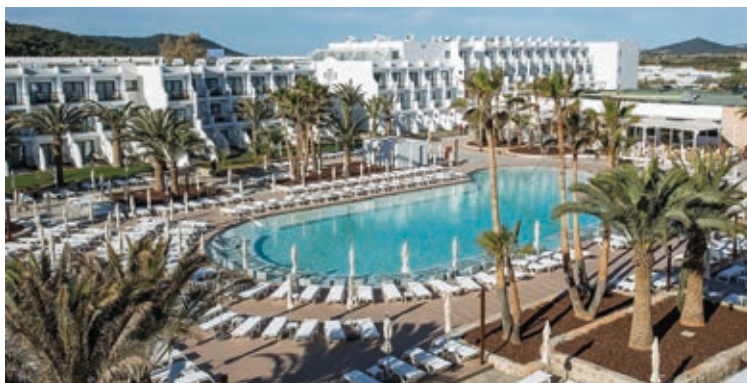
Instalación de 2 IRIDIUM WW (HP90W) mod. 48 Hotel WHITE ISLAND RESORT (Ibiza)
