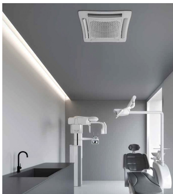
Instalación SKYSAFE en falso techo.
