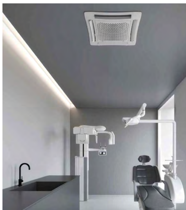
Instalação SKYSAFE em teto falso.
