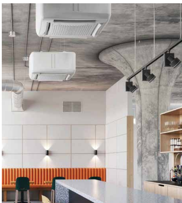
Instalação SKYSAFE à vista.
