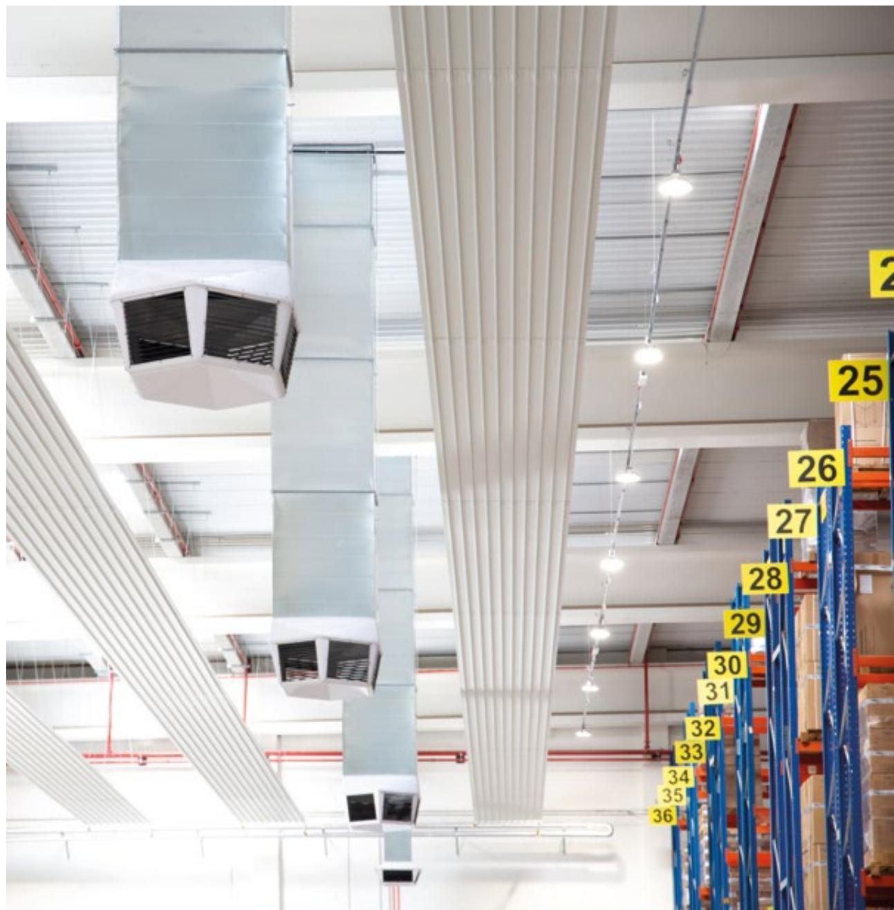
Otra de las ventajas de este tipo de instalación es la eliminación de ruidos de ventiladores (aerotermos) y movimiento de aire en difusores y conductos (roof-top).
