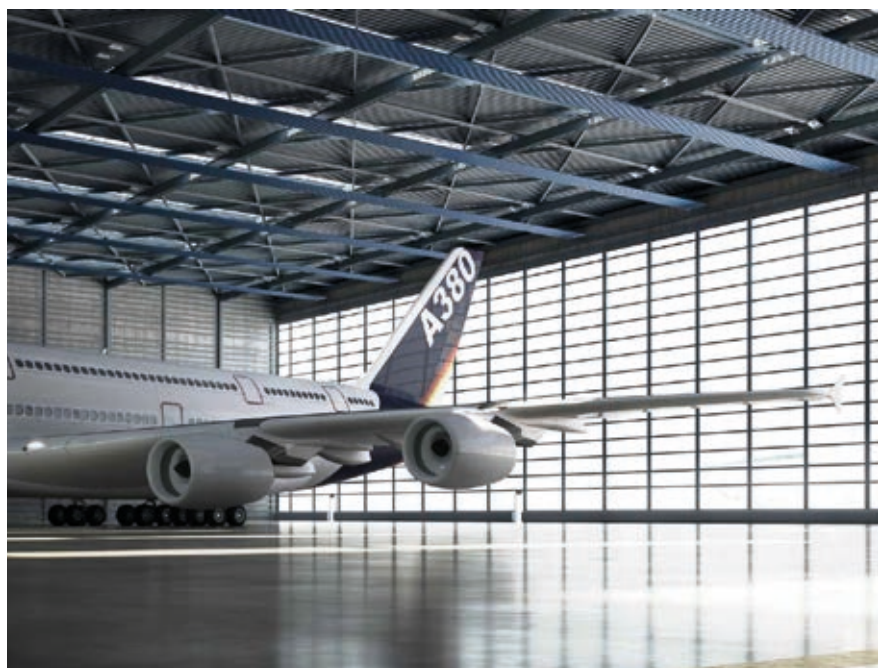
Instalación de paneles DUCK STRIP en las naves de AIRBUS.
